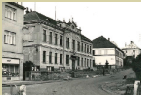
Původní školní budovy
