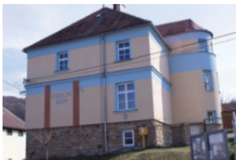
Bývalá škola, dnes budova osadního výboru v Divnicích
