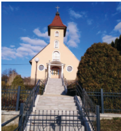
Nově opravená kaple v Nevšové
